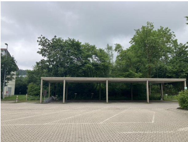
Abbildung 7: Der Erweiterungsbereich des Bestandsgebäudes umfasst im Wesentlichen überdachte Stellplätze.
